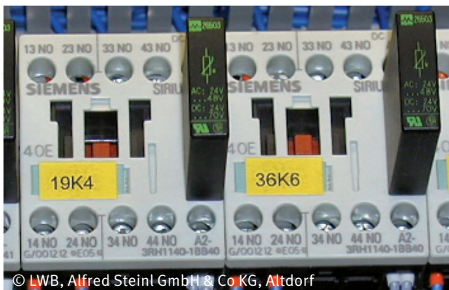
Abbildung 7: Fingersicher ausgeführte Anschlussklemmen an einem Schutz
